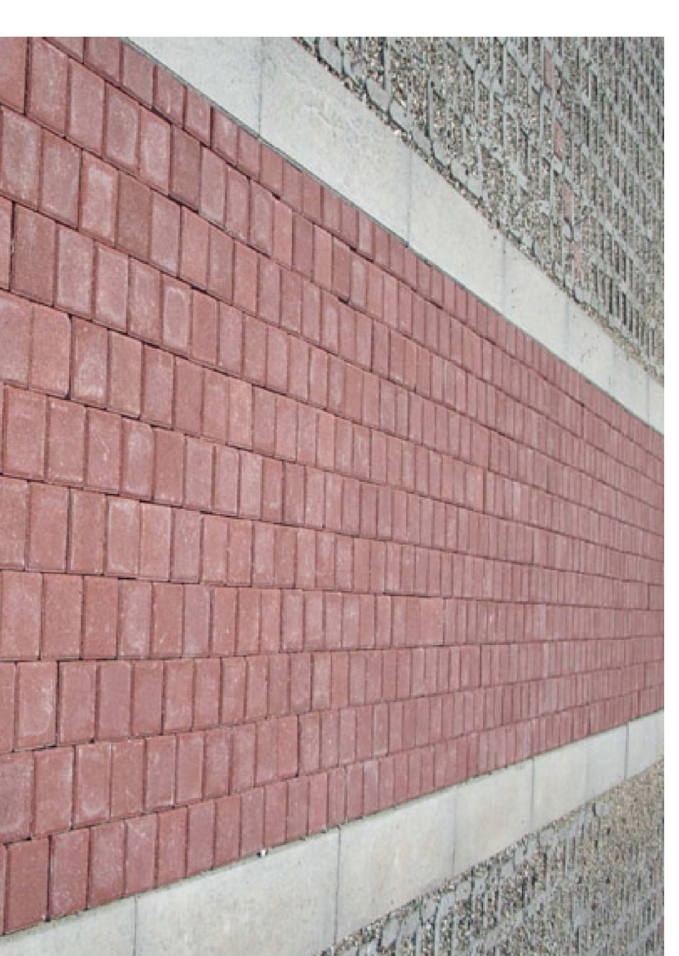
Cordonatura vialetti in cemento
